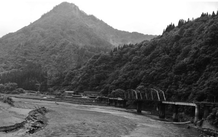
只見町寄岩地内水位低下中 (JR只見線第八只見川橋梁)(令和2年6月撮影)
