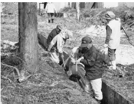
(用水路の土砂上げ)
