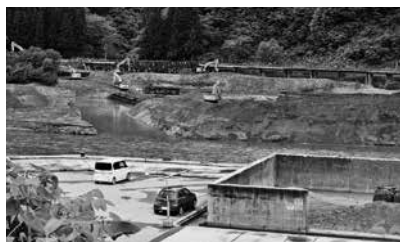
河川内陸上掘削状況 (只見町寄岩付近)
