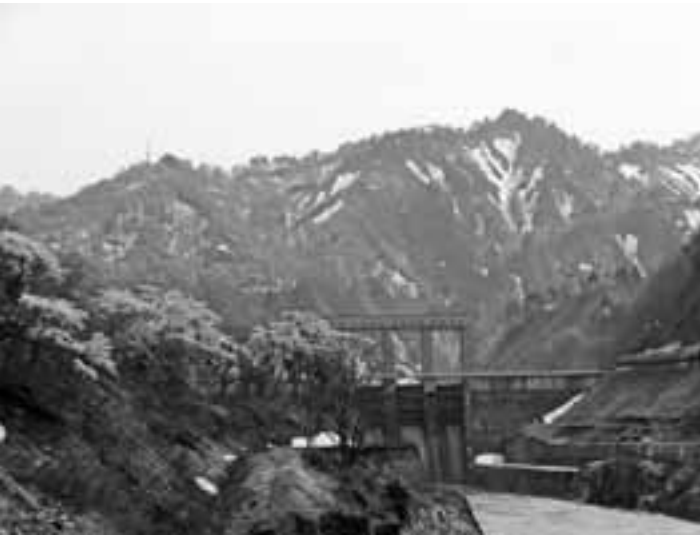
本格的な浚渫作業が始まる滝ダム
