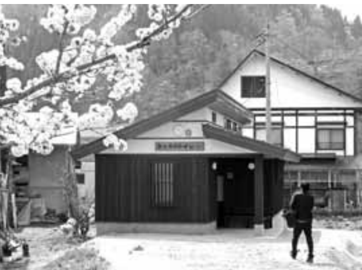
新設になった川口駅前トイレ
