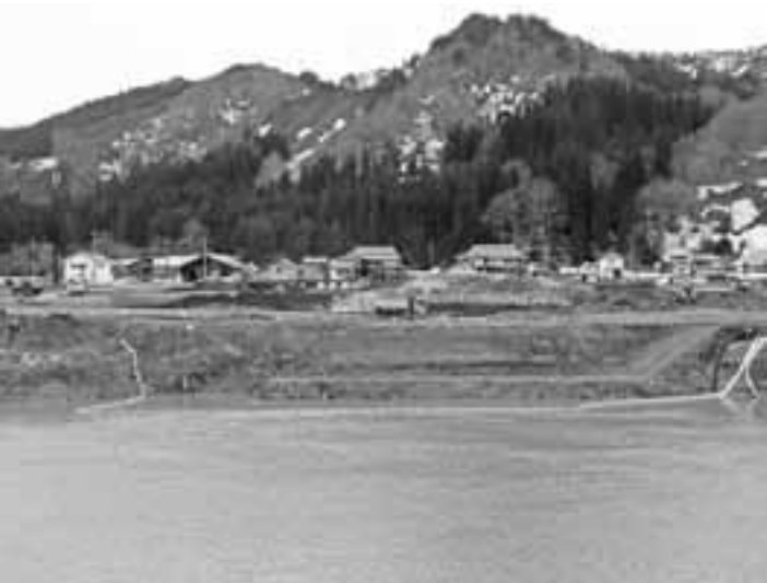
浚渫用船着場の工事が 行われている越川地区
