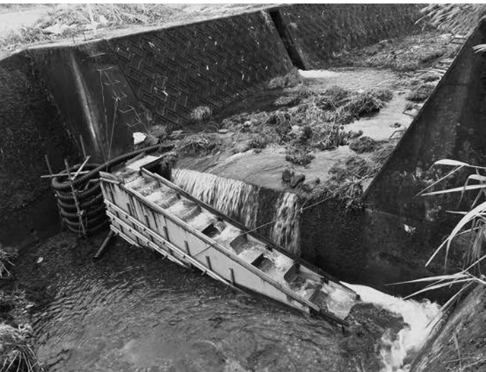
昨年整備された「簡易魚道」 魚道を使い遡上するヒメマスが確認された
