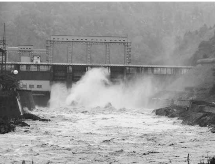
台風21号の影響で放水する滝ダム
