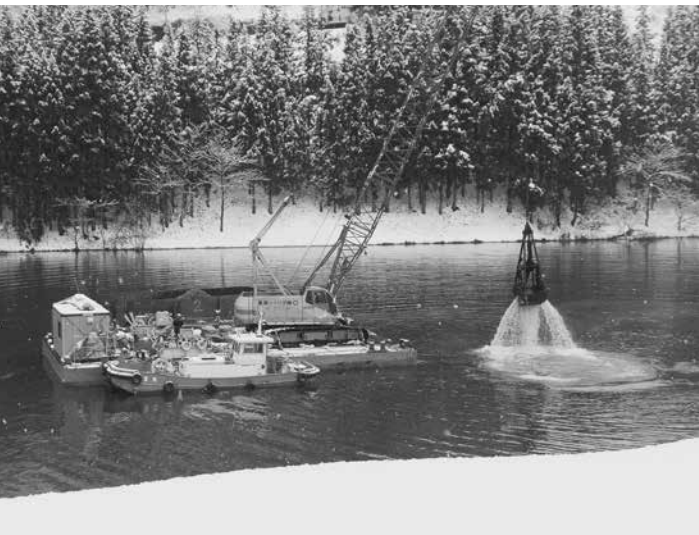
野尻川河口での土砂の浚渫 今回は、20,000㎡の土砂上げ予定
