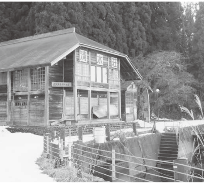
ヒメマス急速冷凍庫を設置予定の「清水荘（沼沢湖畔）」
