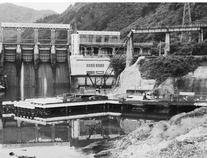
非出水期になり、工事が再開された 本名ダム「道流壁工事」
