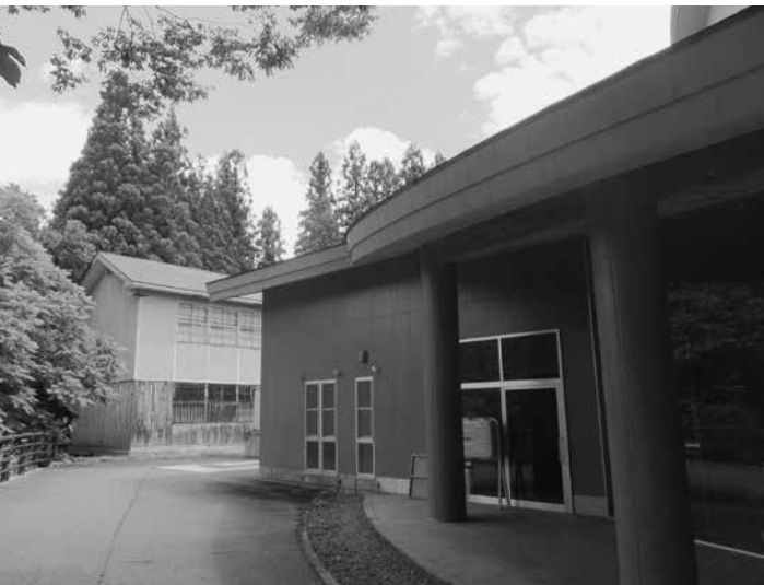
手前が御神楽館 後ろの建物が老朽化した資料室
