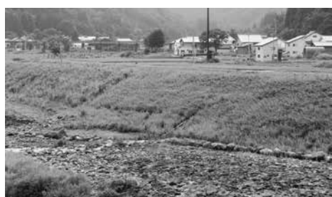
▲築堤が完成した八木沢地区
