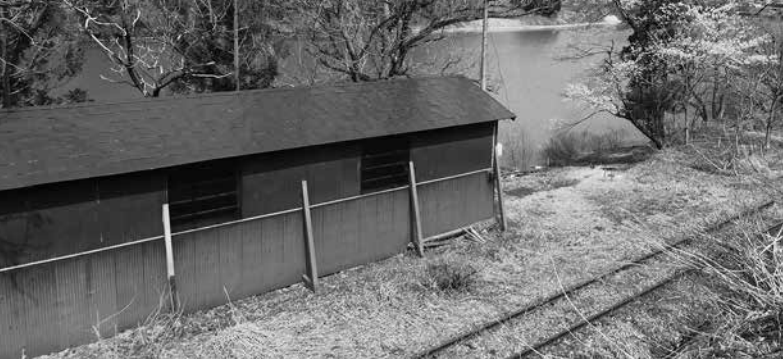
▲棧橋の完成を待つ川高ボート部艇庫
