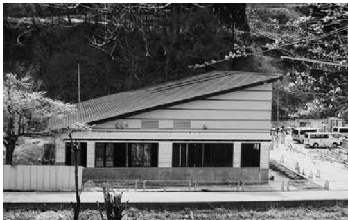
建設中の保養センター
