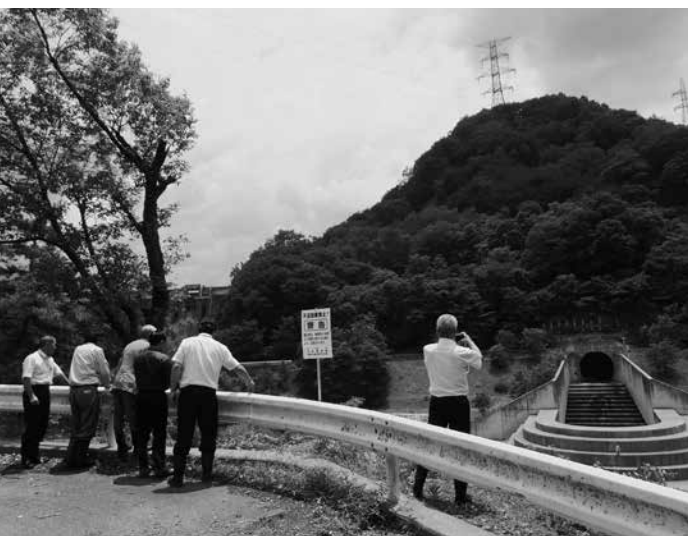
昨年視察した美和ダム（長野県）の導水路
