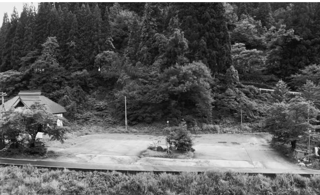
建物の取り壊しが済んだ保養センター改築工事予定地
