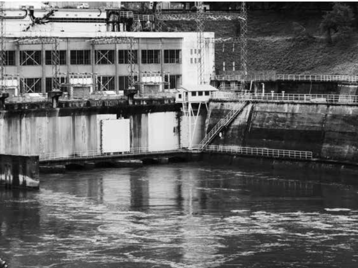
本格運転をする上田ダム
