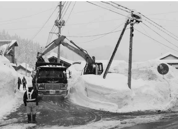
大量の雪で満杯になった雪押し場の「排雪作業」
