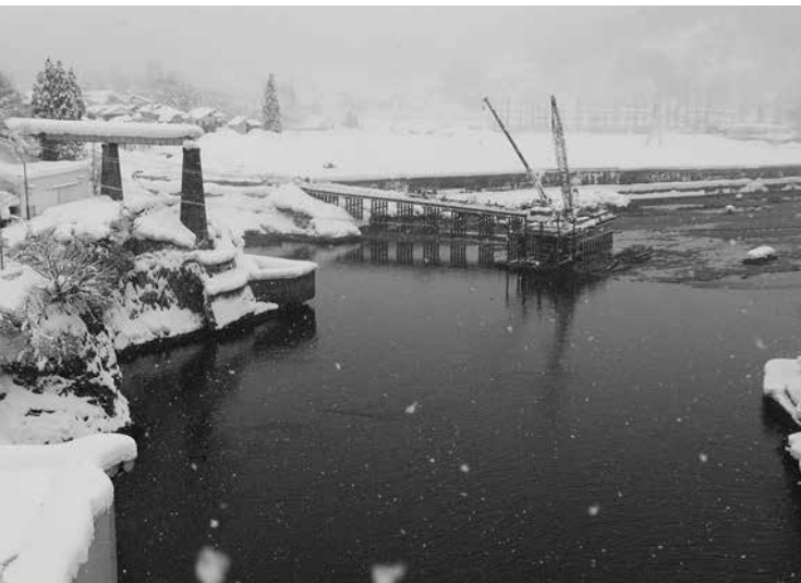
豪雪の中行われているJR第6鉄橋の撤去工事
