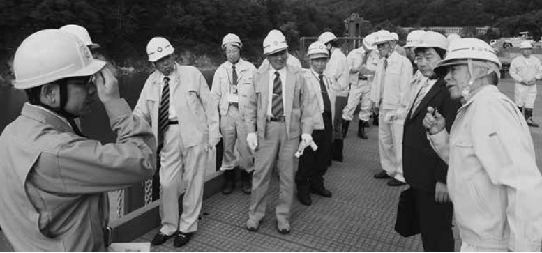
東北電力の浚渫作業「橋立船着場」を視察 H26年10月10日
