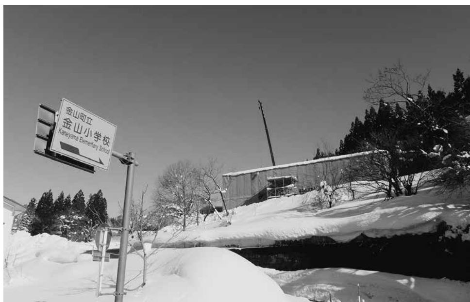
金山小学校近くに建設される定住促進住宅「川口馬場住宅」
