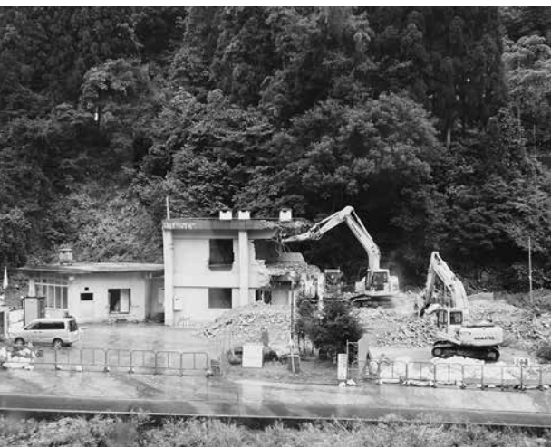
保養センターの解体の様子 跡地には新しい温泉施設が計画されている
