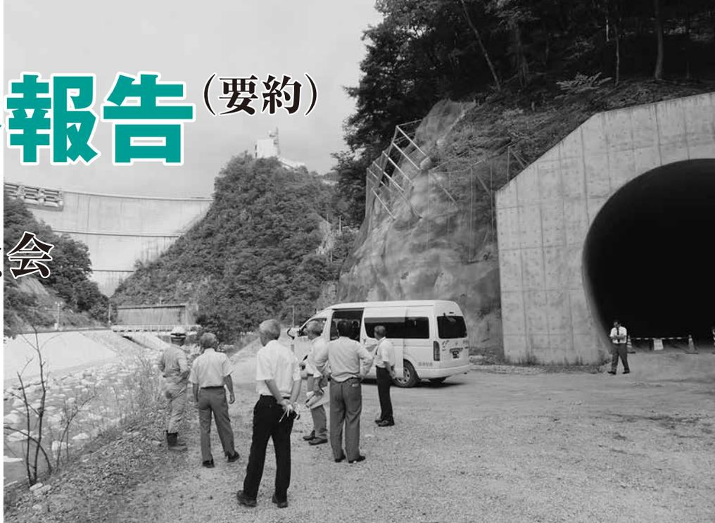
▶小渋ダム(右写真 奥)。平成21年からバイパストンネル(写真右)工事(延長約4km、高さ7.2m、幅7.9m)に着工し、試験運用は平成28年度から。総工費143億3,800万円
