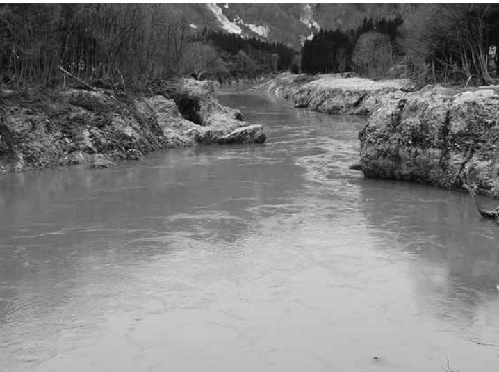
早期の工事着工が望まれる越川の狭窄部
