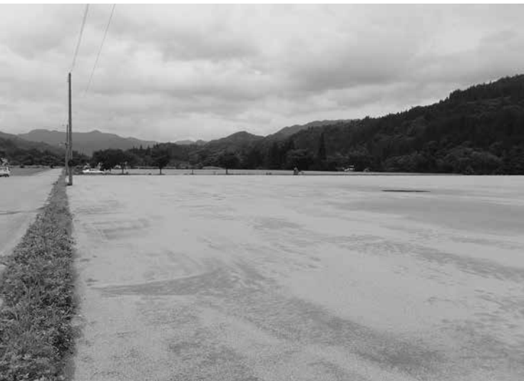
仮整備が進む大塩グラウンド
