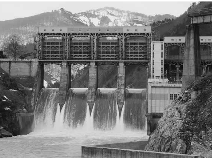
ゲートが上がったままの本名ダム
