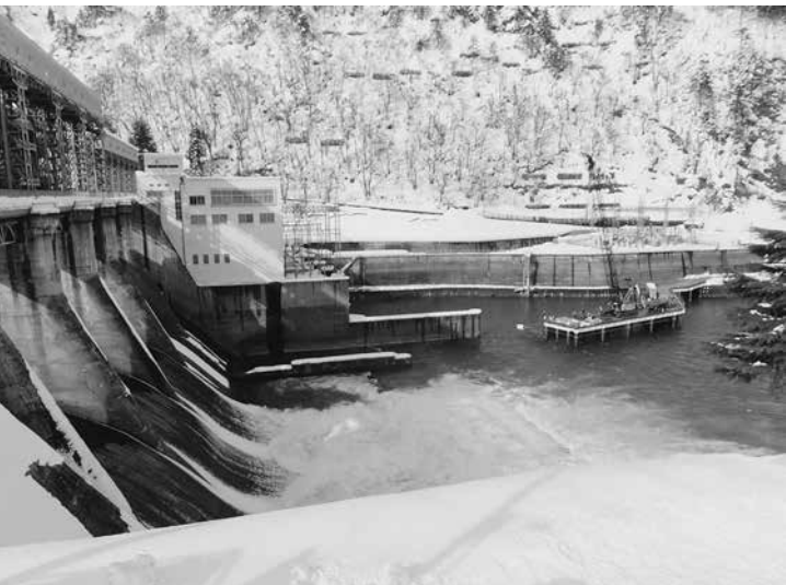
下流の工事が行われている上田ダム
