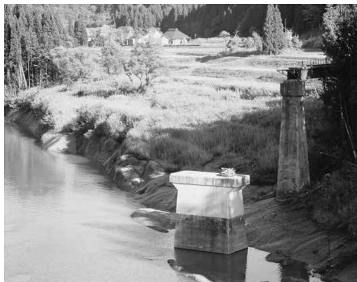
橋桁だけが残るJR只見線（上横田）
