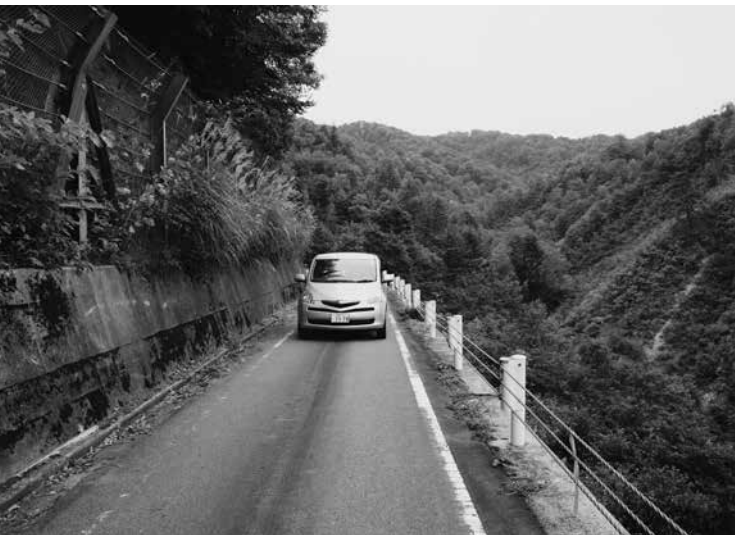
新潟・福島豪雨災害時には生命線となった 県道布沢・横田線（松坂峠）
