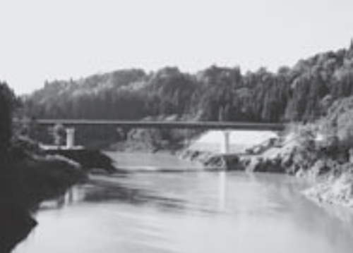
開通目前の二本木橋
