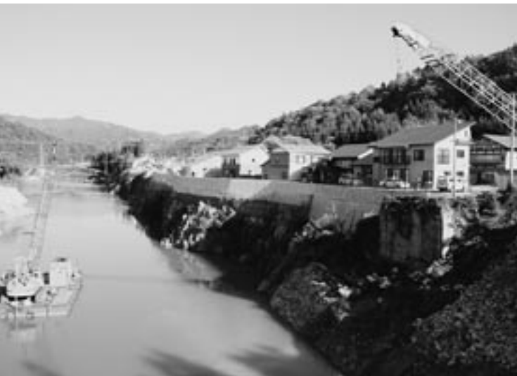
護岸工事とともに住宅の復旧が進む上横田地区
