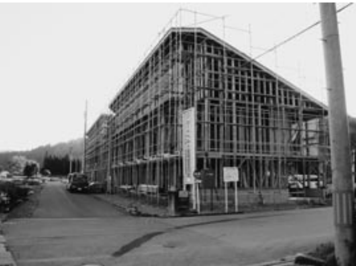
工事が進む町営住宅（手前）とかねやまホーム職員寮
