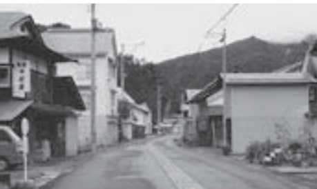
共同排水管が設置される本名地区
