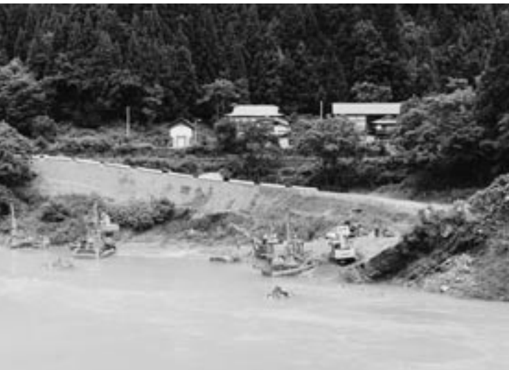
特殊機械で引上げ工事が進む旧西部橋
