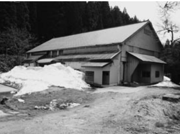
解体し町営住宅建築が予定される旧高崎アパレル
