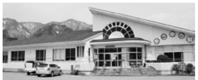
福祉避難所の機能を持った施設に改修される福祉センター
