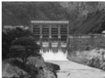
電源開発の滝ダム
