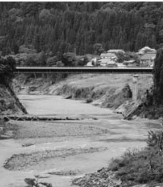
新しい田沢橋の下に流された橋が横たわる
