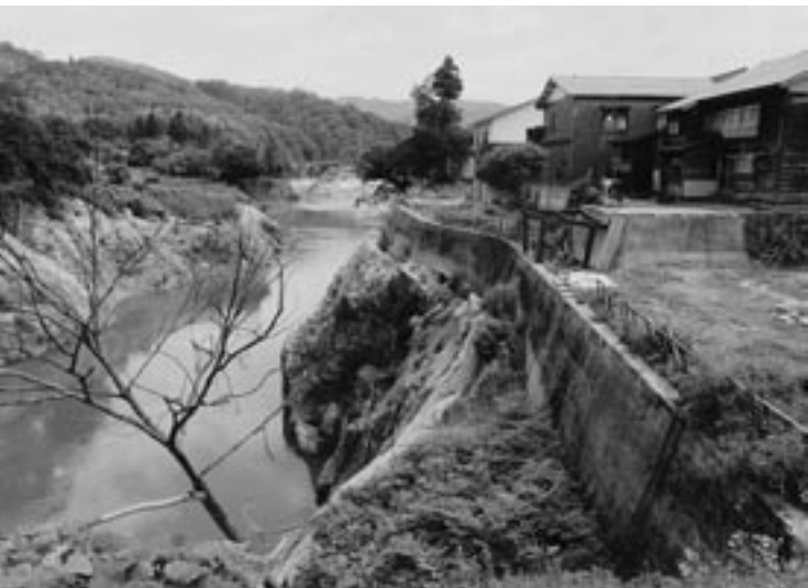
流失した二本木橋は川底にブロックで固定され、川幅を広げる工事が行われる
