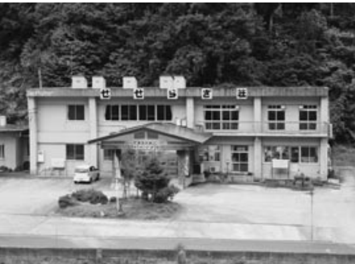
老朽化が進む保養センター
