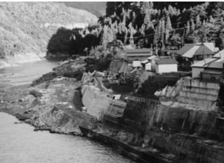
護岸工事が進められる上田地区
