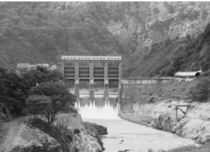
ゲートを全開したままの滝ダム
