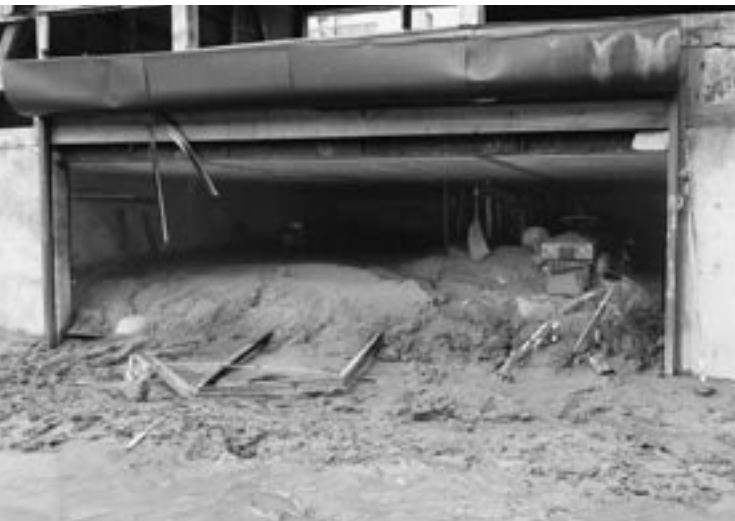
豪雨災害により土砂が流れ込み、被害を受けた農機具や倉庫（越川地区）
