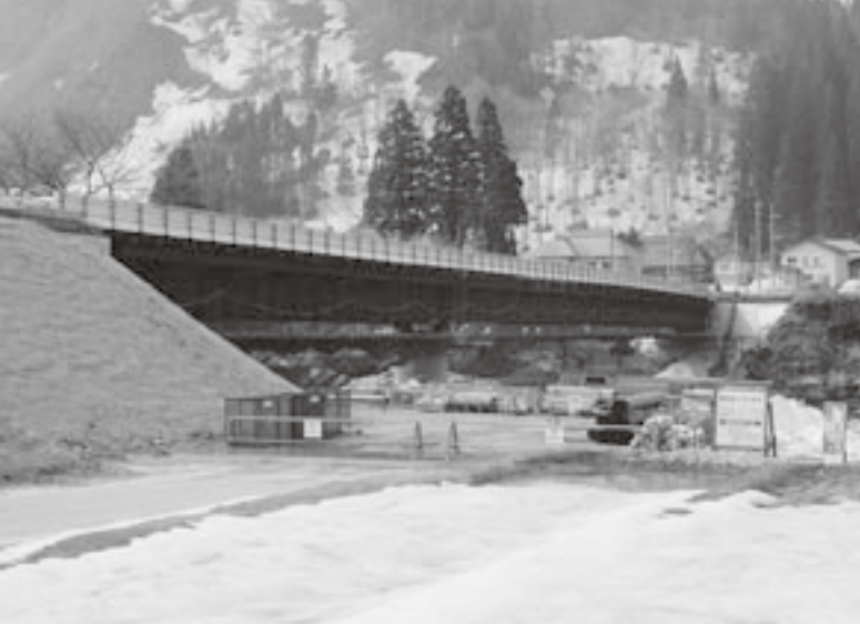
町道滝沢・田沢線で工事が進められる田沢橋
