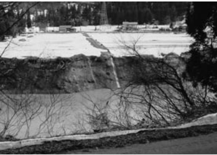
町道土倉・西部線の西部橋建設予定地
