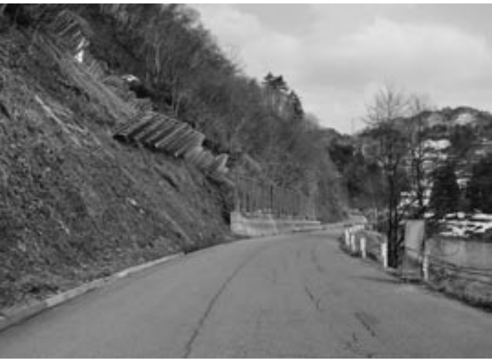
雪崩止めが設置されたが、冬期間の安全確保に苦慮している町道土倉・西部線
