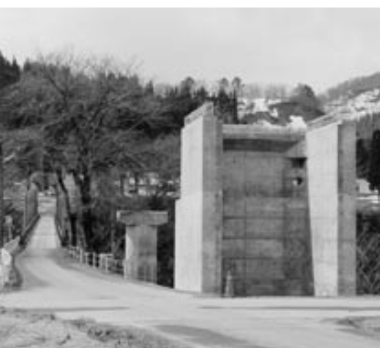
田沢橋の橋台、橋脚まで完了した 「滝沢・田沢線改良工事」
