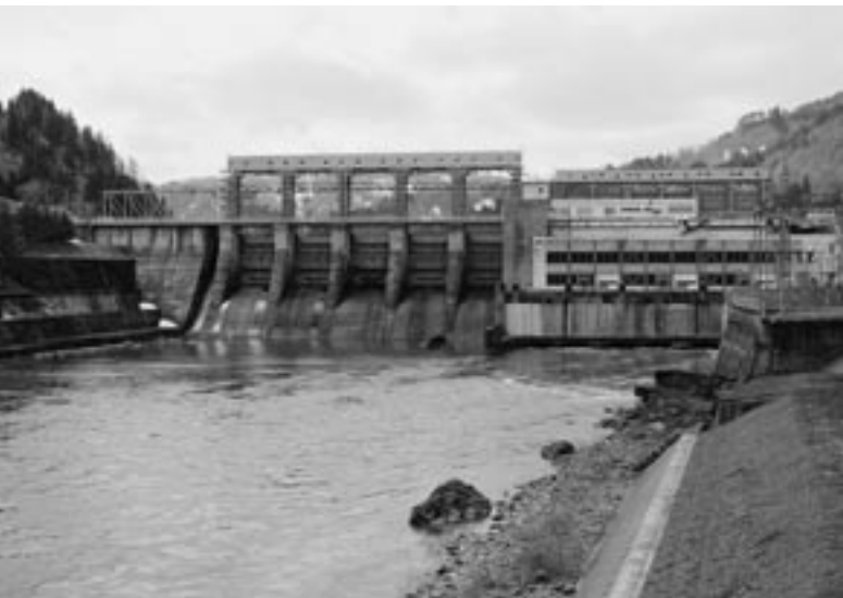
当町内の只見川に設置された中では一番古い 昭和29年3月から運用が開始された上田発電所
