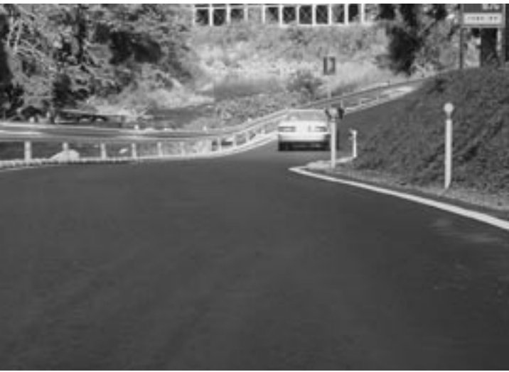
10月1日から片側交互通行ながら24時間通行できるようにになった国道400号（写真は応急的に整備された道路）
