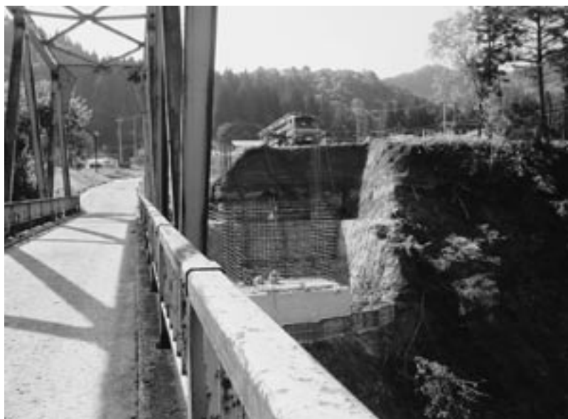
平成20年度から工事が進む滝沢・田沢線改良工事 (平成22年10月18日撮影)
