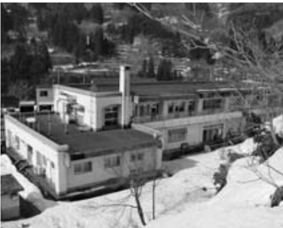
診療所屋上防水工事も「地域活性化交付金」を活用して実施される
