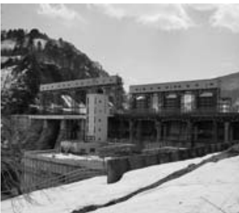
発電所などの大規模償却資産税は平成22年度決算で約2億9,000万円になる。 (写真は本名発電所)
