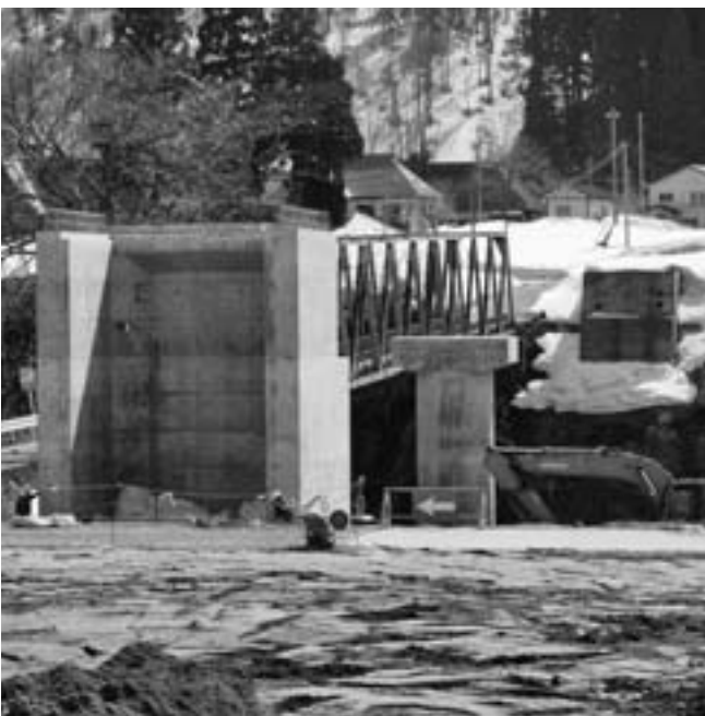
建設進む田沢橋
