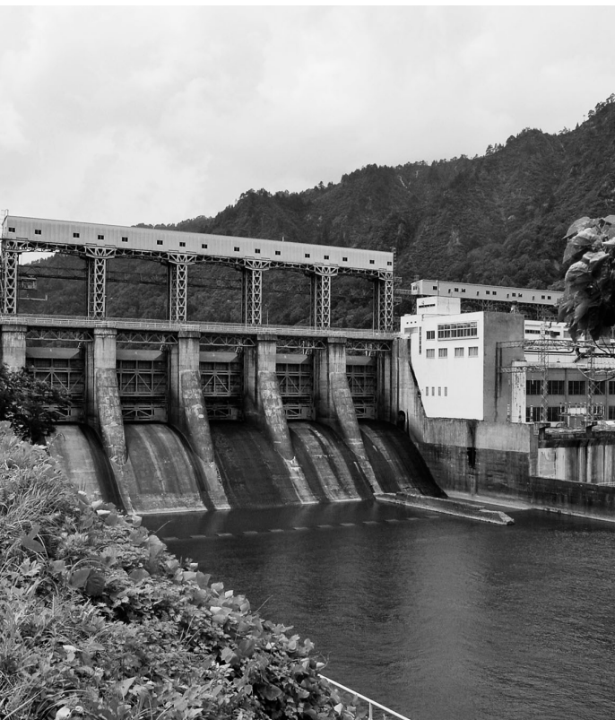
ダムの多い金山町（上田ダム）
