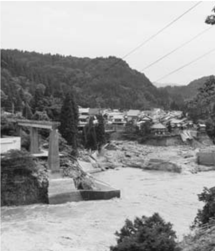
J R 只見線第 6 橋梁も流失した 本名ダム直下
