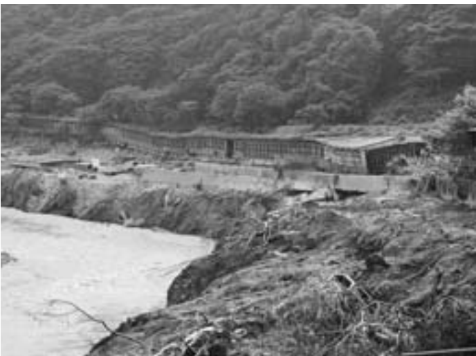
今回の豪雨災害はダム直下の被害が著しい (ズタズタになった滝ダム直下のスノーシート)
