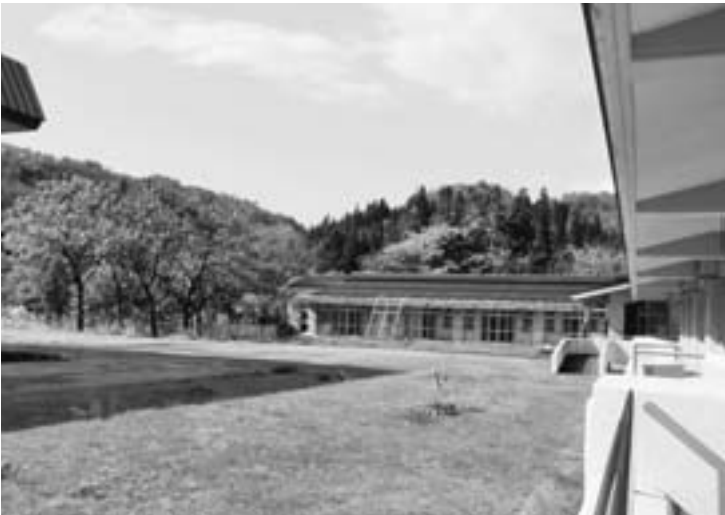
3月の東日本大震災の影響で遅れている「かねやまホーム」の増床工事予定箇所（左側）
