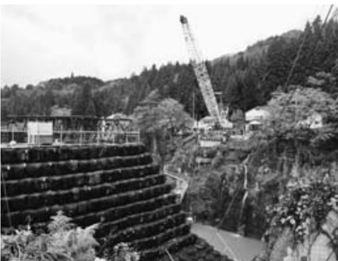
降雪前の仮通行を目指し 工事の進められている二本木橋（11月8日）
