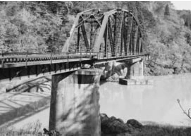
急ピッチで復旧工事の続く只見川第4橋梁（水沼地内）
