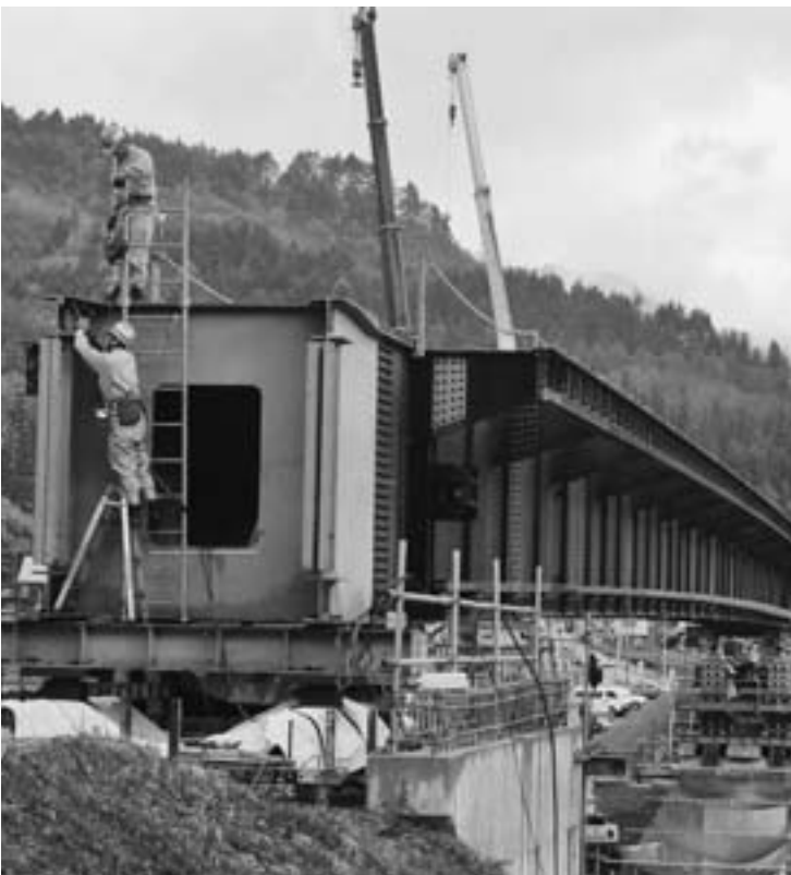
急ピッチで工事の進む新しい田沢橋（11月8日）
