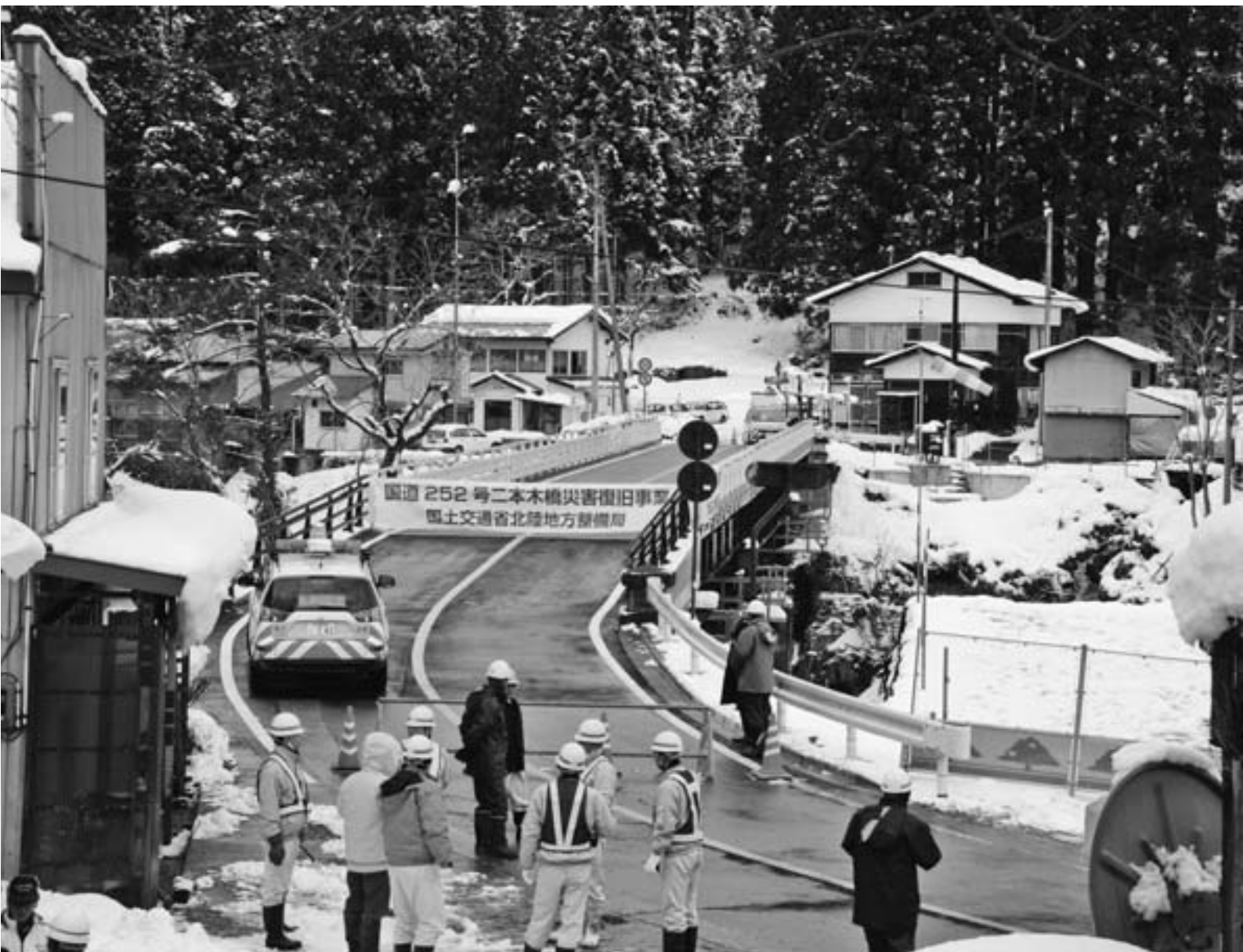
7 月末の豪雨災害で流された国道252号線の二本木橋の仮橋が12月20日に完成
