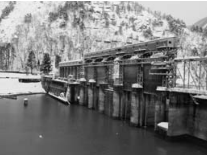
昨年7月の洪水災害後、発電の行われていない 町内発電所（写真は上田発電所）
