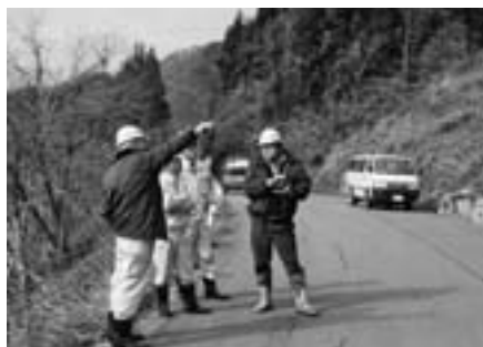
土倉・西部線の雪崩防止 工事箇所の現地調査
