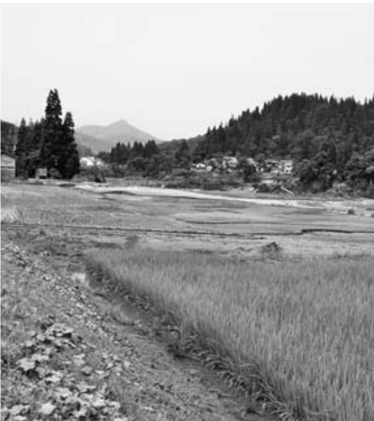
昨年7月の洪水災害で甚大な被害を受けた 越川地区の農地（平成23年8月初旬の状況）
