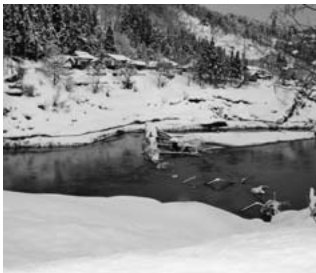
落橋した西部橋
