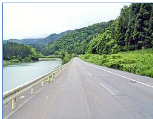
設置場所：JR 只見線早戸駅付近
