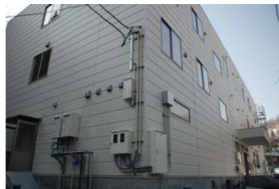
建設中の若桐寮
