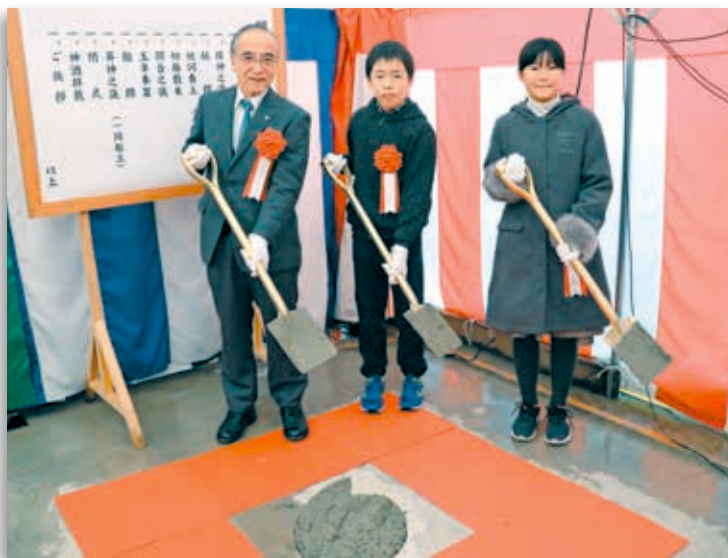
橋の結合部分にコンクリートを入れた押部町長と金山児童
