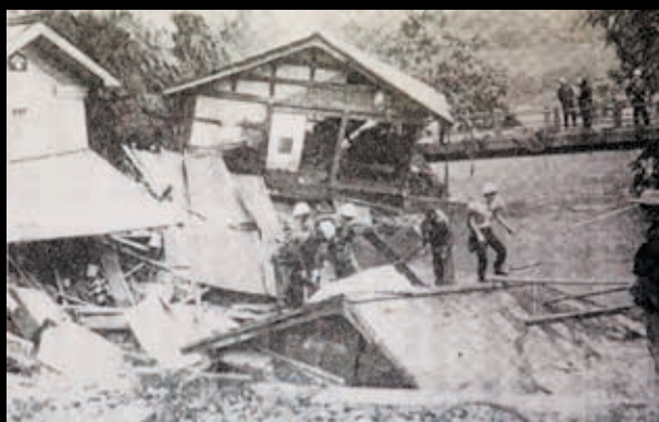
只見川の氾濫で最も大きな被害を受けた上大牧地区
