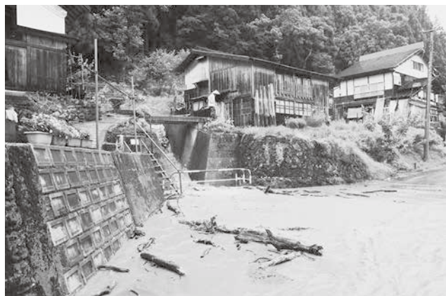
水路から溢れた水が道路に流れ込んだ 川口栗ノ牧地内（7月18日）
