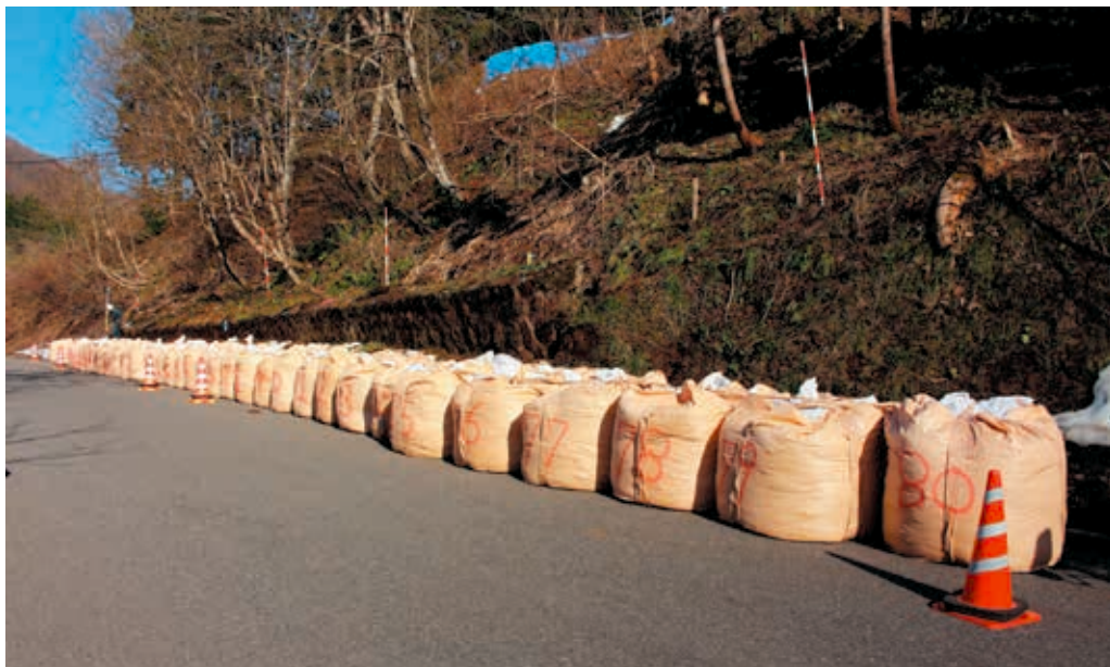
大型土のうが積まれた現場
