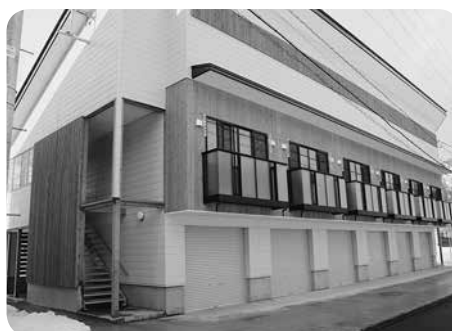
中川地区に建築された町営住宅
