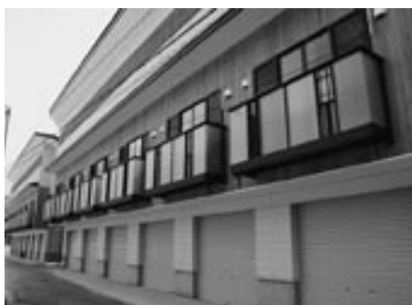
完成した町営住宅
