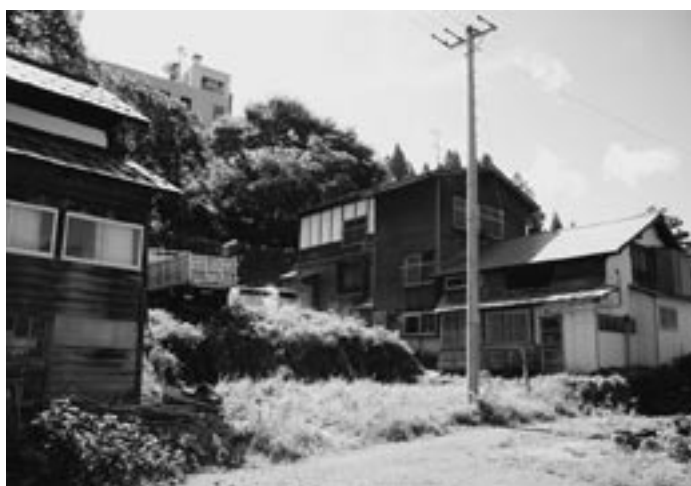
川口高校新学生寮の建設予定地（川口）
