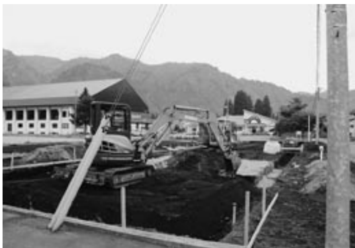
住宅建設工事が始まった現場（中川）
