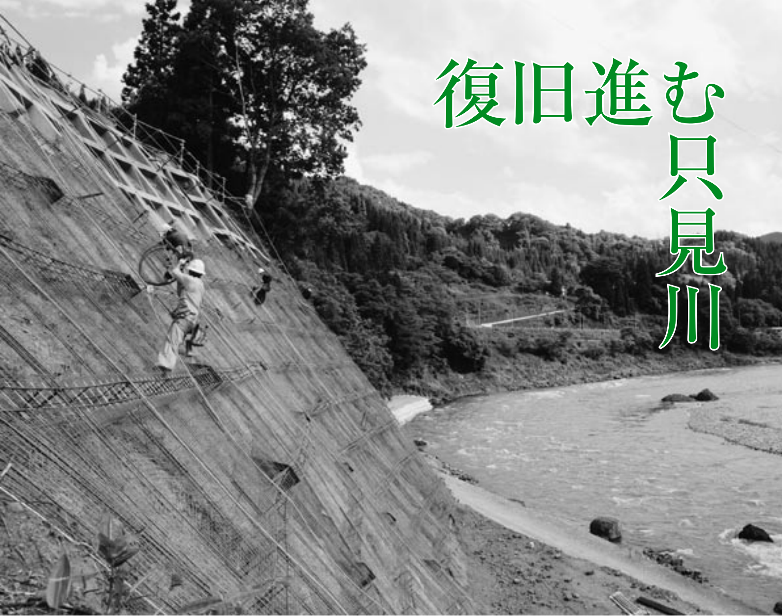
只見川沿いの工事現場（西谷字牧ノ戸付近）
