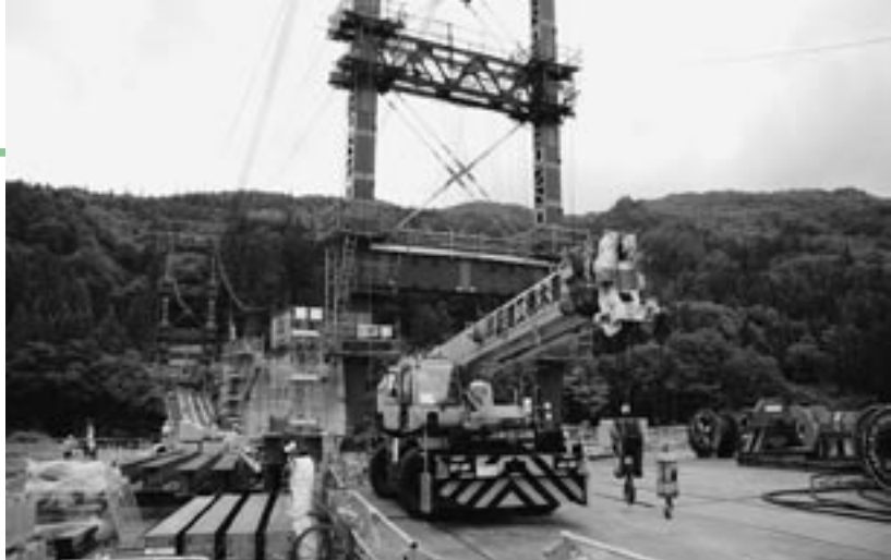
旧西部橋より上流に架かる西部橋工事現場
