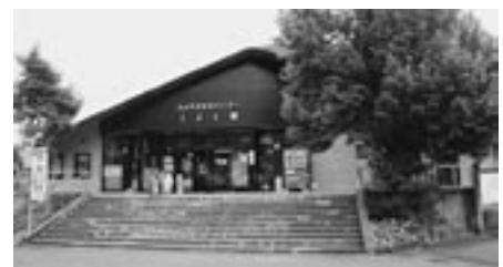
改修されるこぶし館
