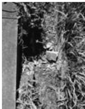
雷によって破損したU字溝
