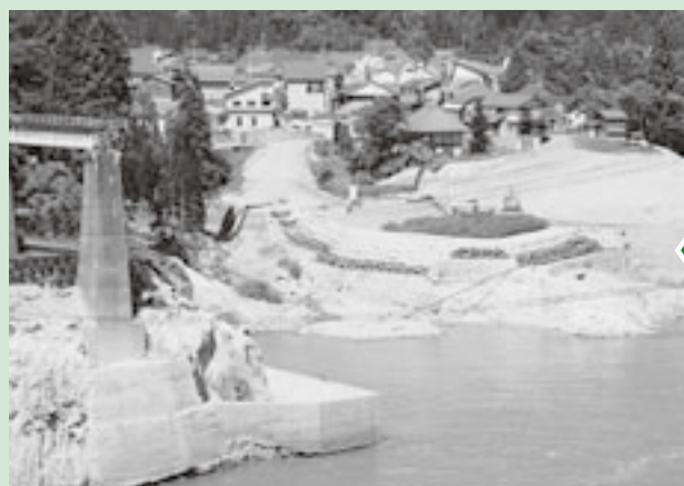
増水により崩落した陣場の工事箇所
