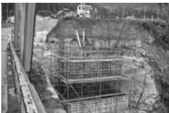
工事が進む田沢橋
