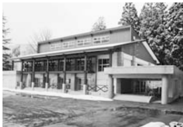
新築された金山小学校の体育館
