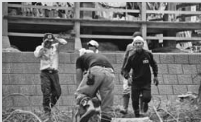
伊夜彦神社（横田）では長期間に渡って撤去作業が行われました
