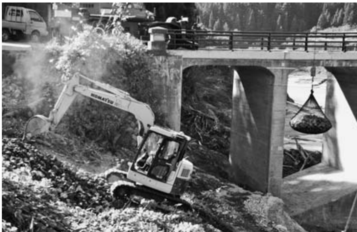
急ピッチで進められる仮橋設置工事（二本木橋）
