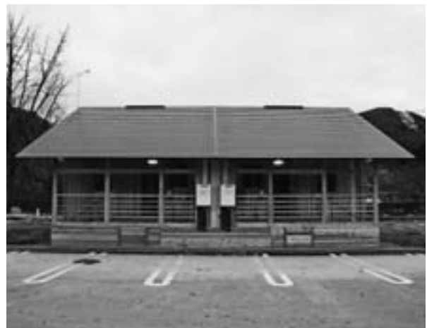
完成した木造仮設住宅(本名)
