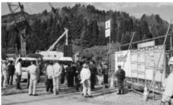
二本木橋仮設工事現場の視察
