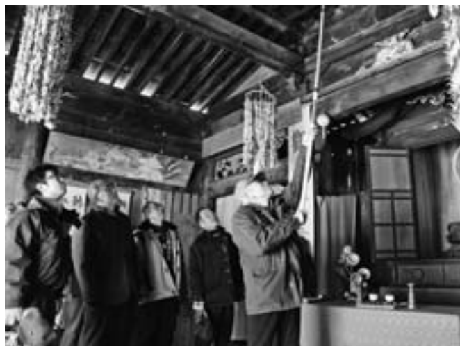
火災報知器の点検をする参加者（宮崎大悲堂）
