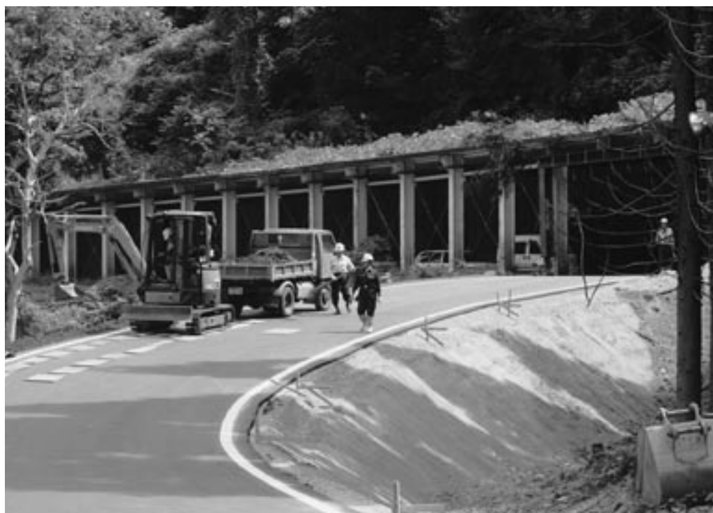
整備が進む工事用道路
