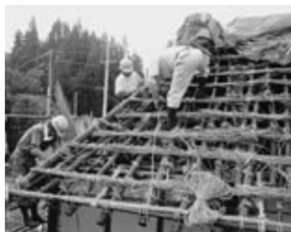
旧五十島家住宅で進む茅の吹き替え作業
