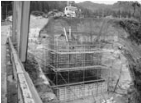
工事が進む町道滝沢田沢線
