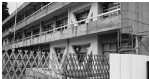
耐震工事が進む金山小学校
