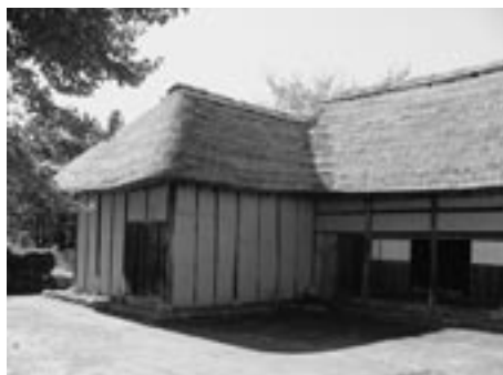
葺替が完了した旧五十島家住宅
